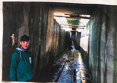
Součástí mlýnka je hráz. Pool, hráz, se nechává vyprázdnit. Hráz se betonová a piládrová.
